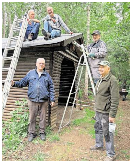
Ehrenamtliche haben die Schachhütte im Waldgebiet Mörse bei Dedenhausen instandgesetzt: Günther Brandes (auf dem Dach, von links) und Dirk Voigtländer, Wilhelm Schmolke (auf der Leiter) sowie Georg Meschner (am Boden, von links) und Reinhard Brandes.
