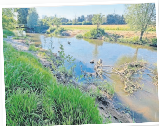
Die abgeflachte Böschung konnte gut mit Schwarzerlen bepflanzt werden.
