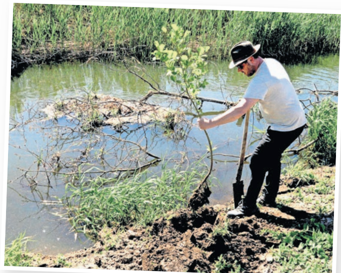
Einige Bäume konnte Sören Brose direkt an den Böschungsfuß setzen. Dort gelangen die Wurzeln auch im Sommer schnell ans Wasser und halten die Böschung fest.
