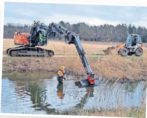
Bei der Revitalisierungsmaßnahme an der Fuhse sind auch Bagger zum Einsatz gekommen.
